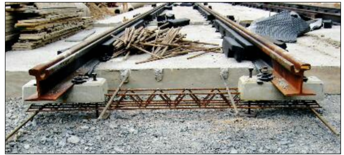
3. RHEDA-CITY-Oberbau eines Gleises mit Quer- und Längsbewehrung
