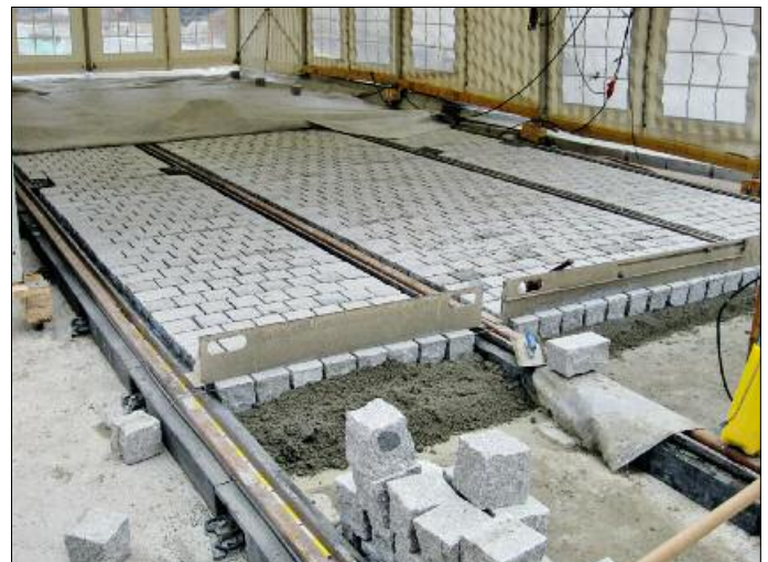
5. Ausführung der Pflasterarbeiten
